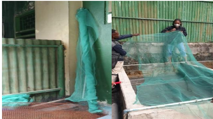
Gambar 4. Pemasangan Jaring Pelindung
