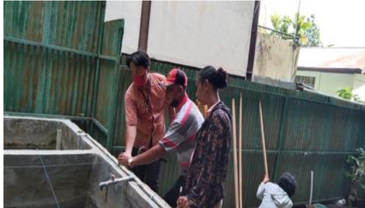
Gambar 2. Pemasangan instalasi tempat peletakan selang aerator
