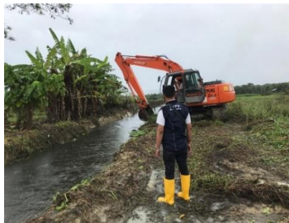
Gambar 5. Pengerukan Sedimen Sumber: Anonim, 2021
