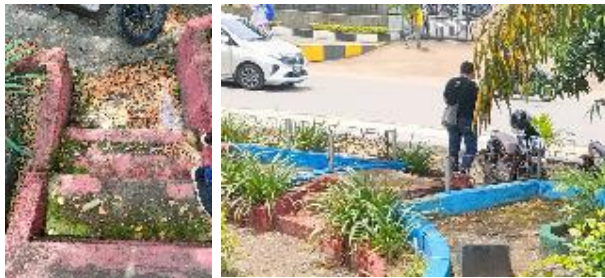
Gambar 2. Pintu masuk sisi
