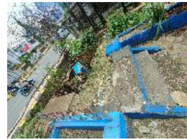
Gambar 3. Pintu masuk sisi
